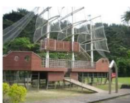
長寿命化を図る 遊具施設
