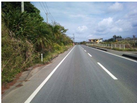
⑪幹線道路沿いの修景植栽
