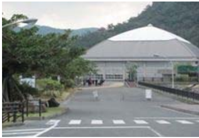
⑦ 広場の改修が望まれる入口部
