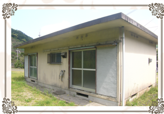
建物外観 (鉄筋コンクリート造平屋)
