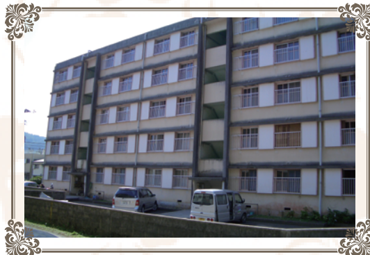
建物外観 (鉄筋コンクリート)
