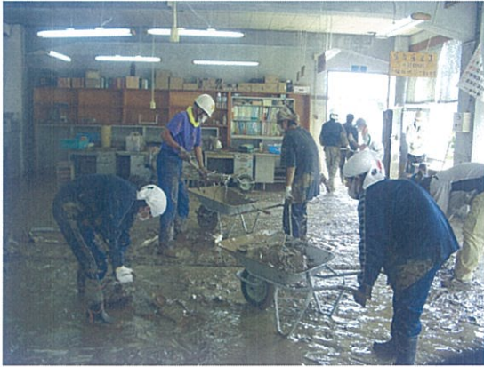
災害後の作業の様子(住用総合支所)
