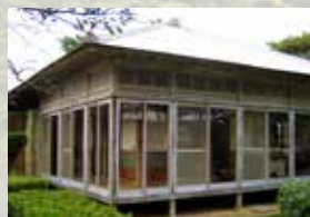
屋根ふき替え修理前 (おもて)
