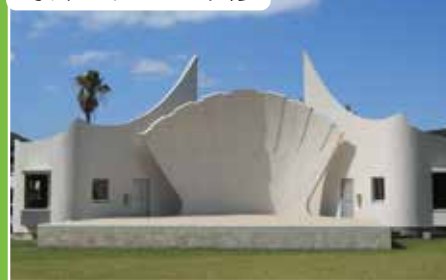
野外ステージ改修
