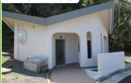
駐車場トイレ改修
