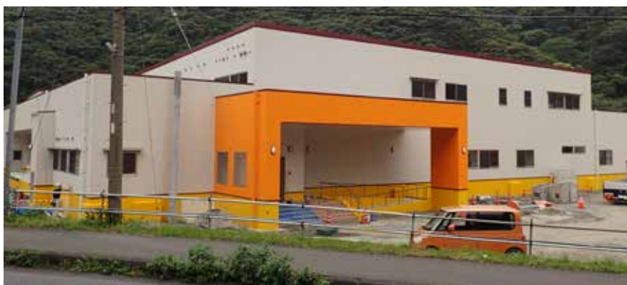
【9月（2学期）からの運用開始に向け、現在も工事を行っています。】
