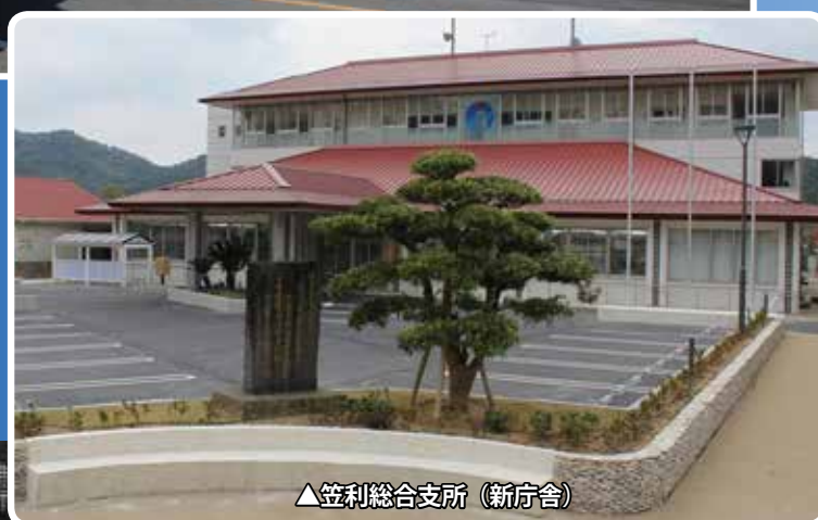
▲住用総合支所（新庁舎）
