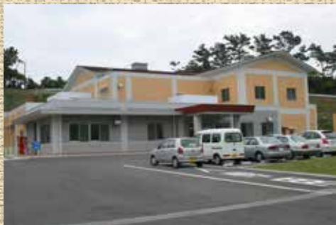
H20. 4. 28 有良汚泥再生処理センター竣工
