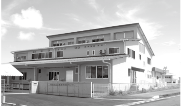
【完成した奄美市立笠利学校給食センター】
