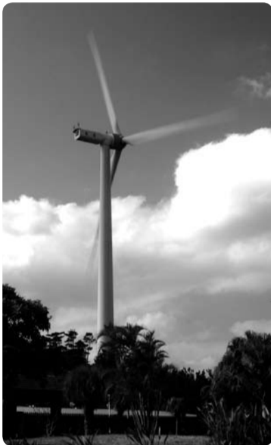
【本格稼働を開始した風力発電所】ブレード(プロペラ)まで入れると高さは約107メートルです。
