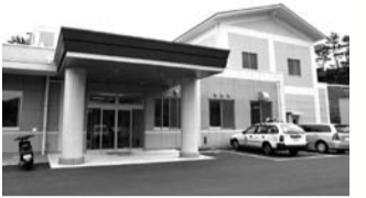
【汚泥再生処理センター】
