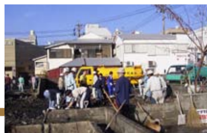
建友会による災害復旧の様子
