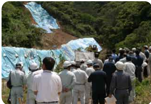
【名瀬鳩浜沢の現場】
