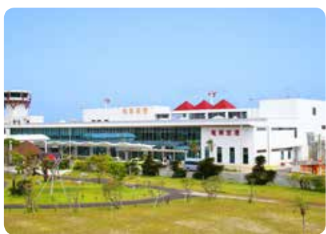
奄美空港ターミナルビル
