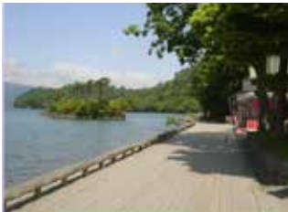
【歩道 (ウッドデッキ)】
